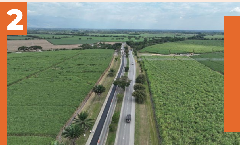
Comenzó construcción de vías 5G en el país por parte del Gobierno del Cambio. Foto ANI
