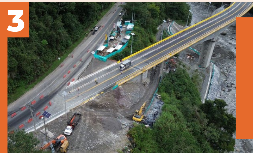
Viaducto kilómetro 58 está en 98 % de ejecución. Foto Invías
