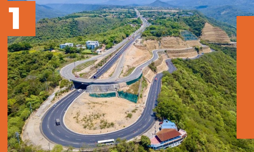
Vía Bogotá - Girardot alcanzó un avance de 73,52 %. Foto ANI
